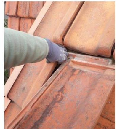
Nachdem alle Ziegel wieder sitzen, werden die HDC-Schienen auf den Dachhaken befestigt. Dazu wird an jedem Dachhaken die Mutter gelöst, die nach oben zeigt, und die HDC-Schiene in der dafür vorgesehenen Nut eingeklemmt. Die HDC-Schiene sollte auf allen Haken gut aufliegen und nicht durch das Anschrauben verzogen werden. Dafür können die Dachhaken zusätzlich justiert werden, wenn die Mutter gelöst wird, die Richtung Traufe zeigt.
