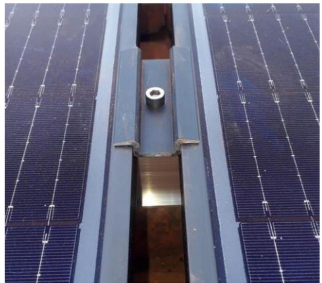
reinclippen und sanft anziehen. Jetzt könnt ihr das zweite Modul danebenlegen, die Mittelklemme etwas lösen, Position nachjustieren, die weiteren Randklemmen einclippen und dann alle Modulklemmen festziehen.
